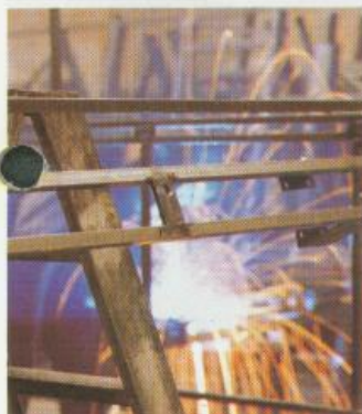
Geschweißter Stahlprofilrahmen des Hymermobils.
