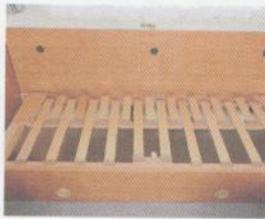
Gasdruckfedern, die den Lattenrost nach oben drücken, erleichtern das Hochklappen der Betten und ermöglichen somit eine leichte Zugänglichkeit zu den großen Stauräumen.
